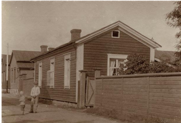
Rännikadun varren puurakennuksia 1800-luvun lopussa.
